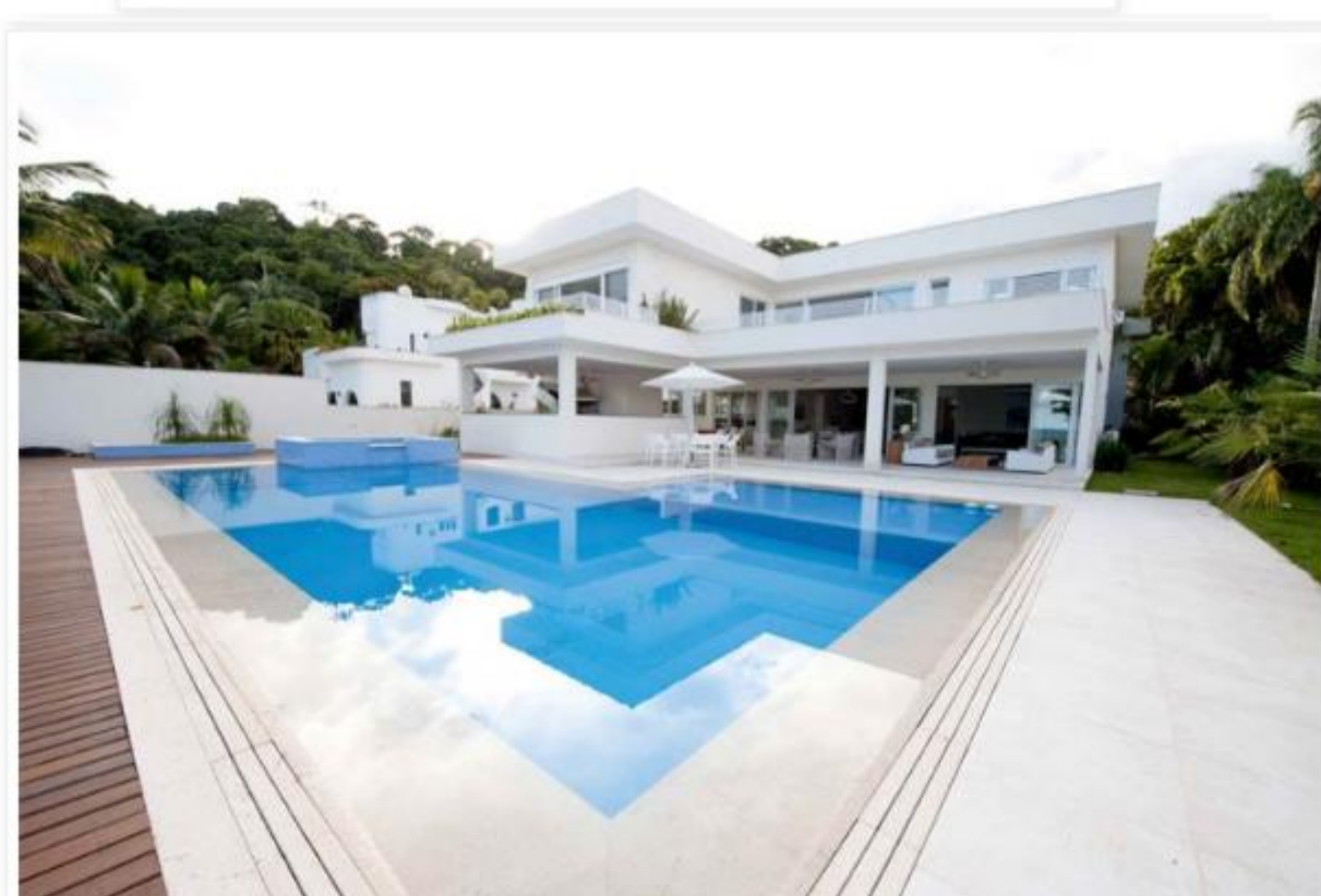
Piscina de pastilha com degraus e prainha + borda tipo praia de cimentício + piso de cimentícios + deck de madeira. Projeto Selma Tammaro .
